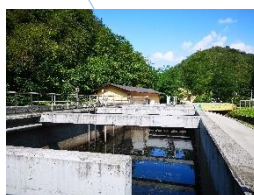
Centralna čistilna naprava
