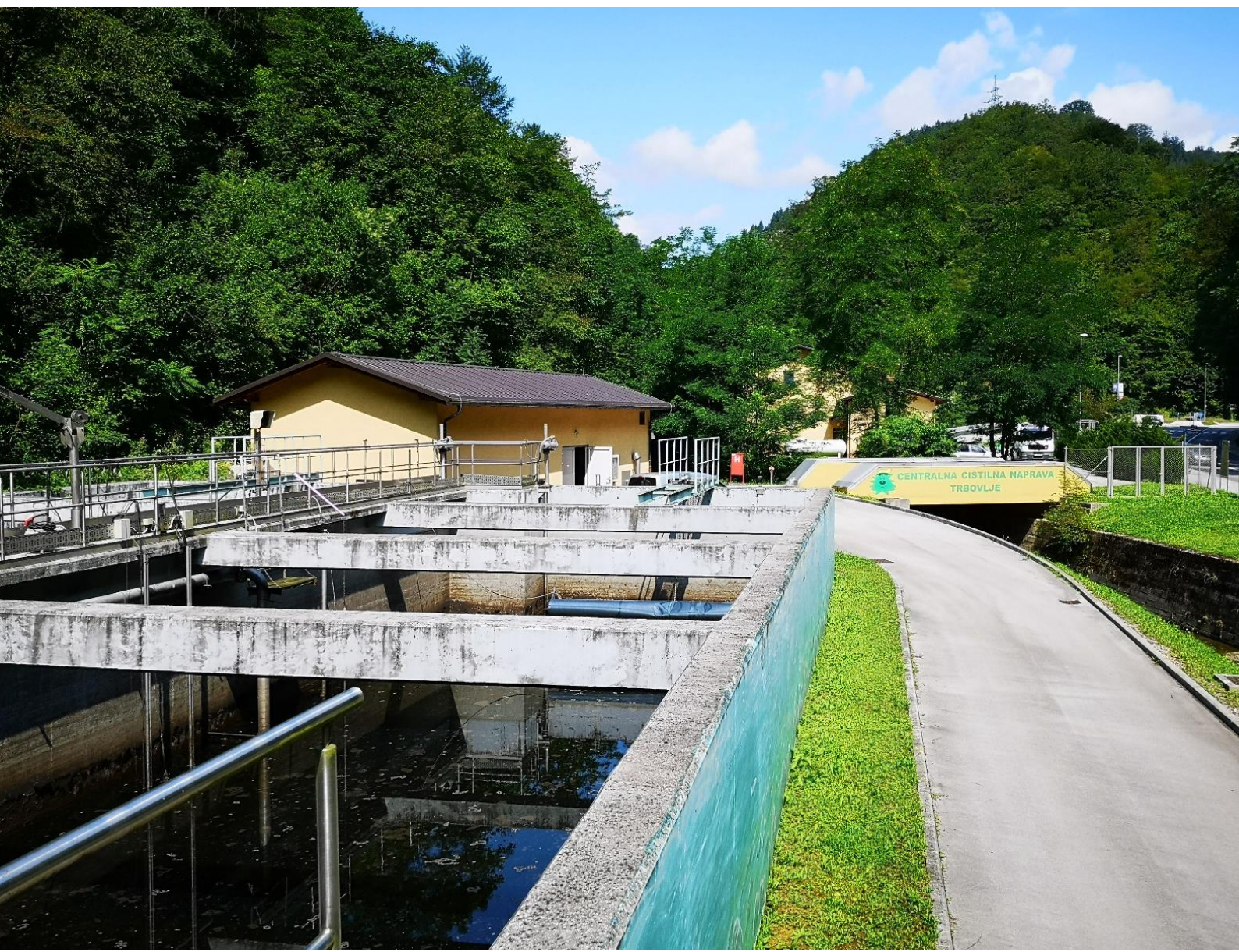
Slika 3: Pogled z bazenov centralne čistilne naprave
