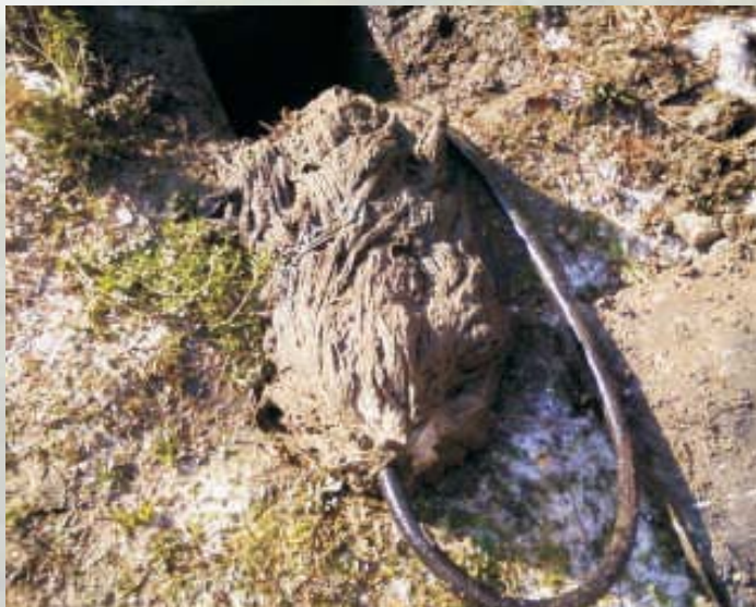
Zamašitev hišnega priključka s sintetičnim povojem
