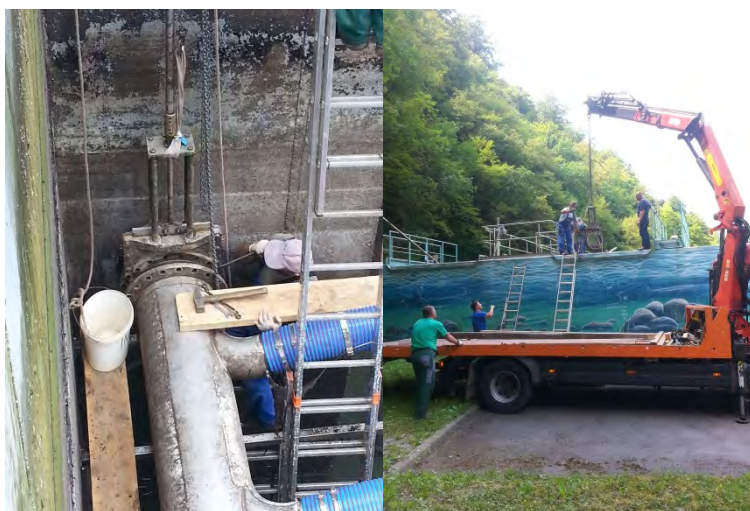
Odstranitev in transport zaporne lopute
