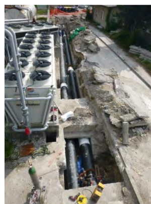
Obnova vročevoda ob Toplarni Polaj
