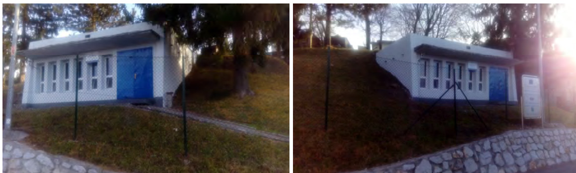
Vodohran Vreskovo po obnovi
