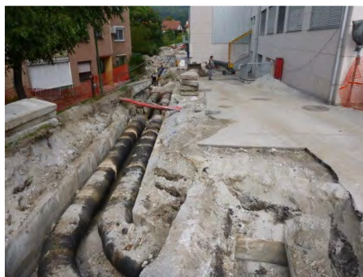
Vročevod pred obnovo poleg STPŠ
