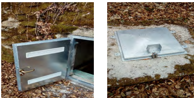
Nova vrata zajetje Bokal rov in pokrov jaška zajetje Bokal
