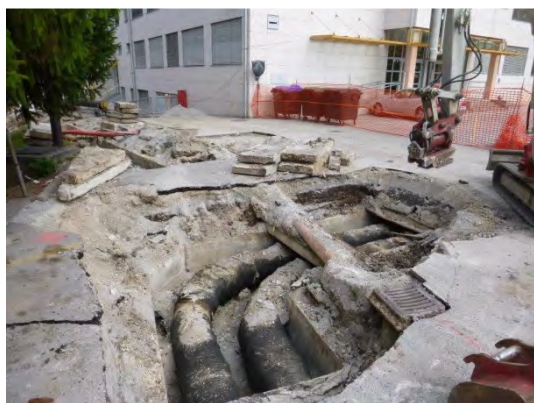
Vročevod pred obnovo Šuštarjeva 1
