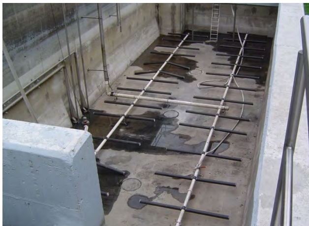
Puhala na dnu izpraznjenega in očiščenega SB
