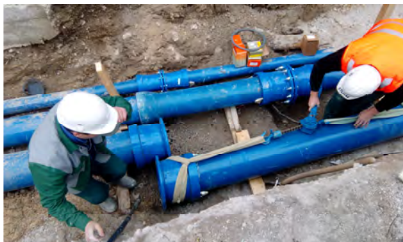
Obnova po skalnem podoru
