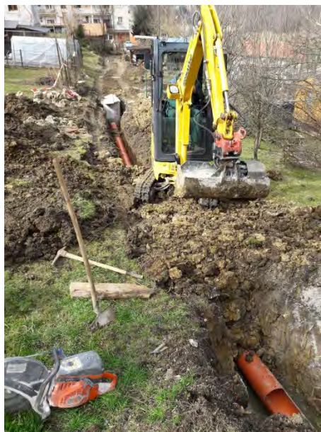
Obnova sekundarnega kanala Kolonija 1. maja
