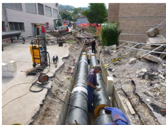
Obnova vročevoda pri Šporni dvorani Polaj
