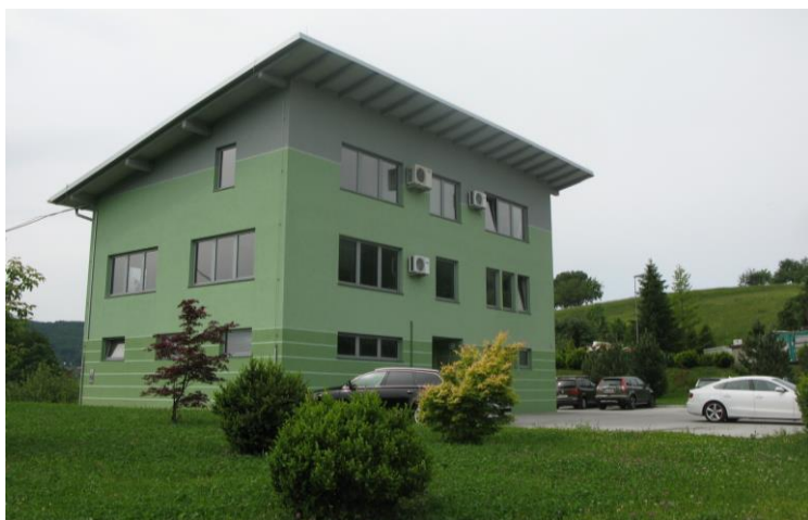
CEROZ – poslovna stavba
