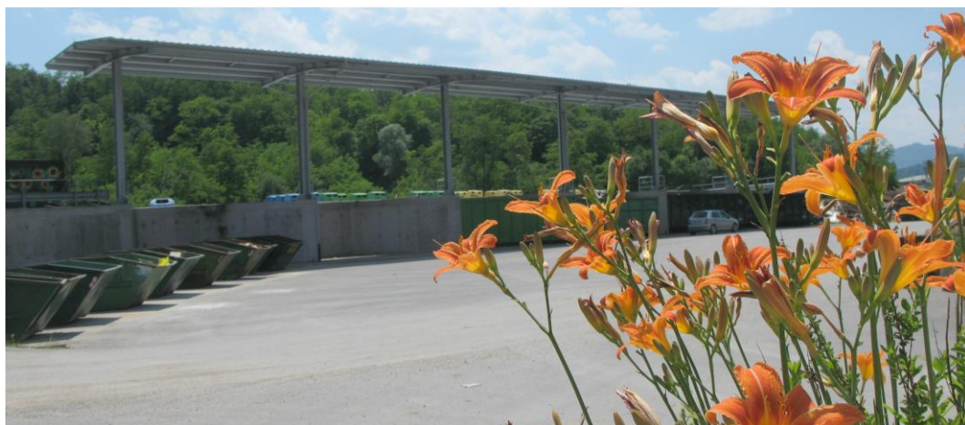
Slika št. 3: Zbirni center Neža – iztresalna rampa
