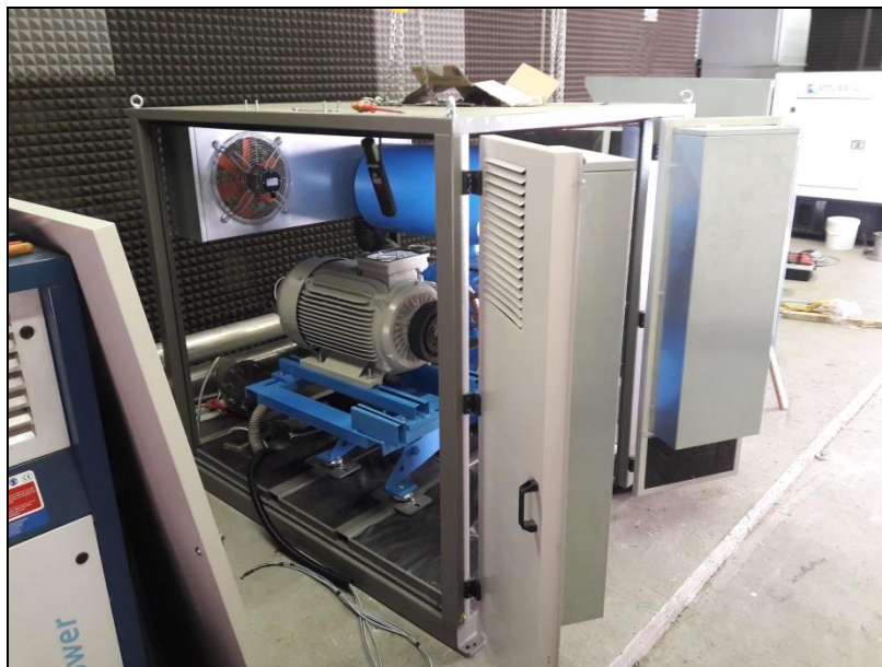
Slika št. 2: Zamenjava puhala na CČN Trbovlje
