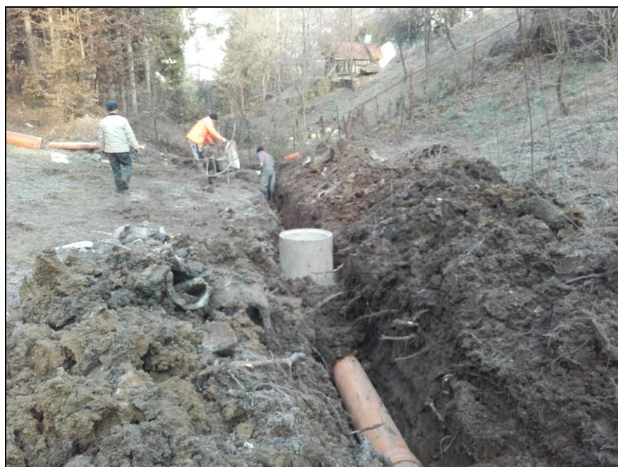
Slika št. 3: Obnovitvena dela na kanalizacijskem omrežju
