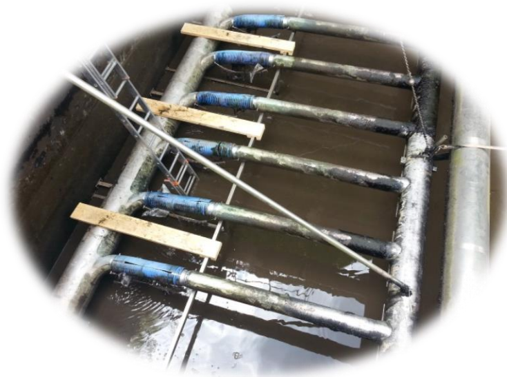
Demontaža prelivnega žleba
