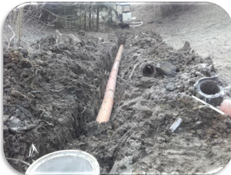
Obnova meteornega kanala RVV Dom in vrt - DUFS
