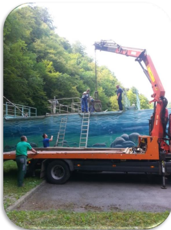
Demontaža prelivnega žleba
