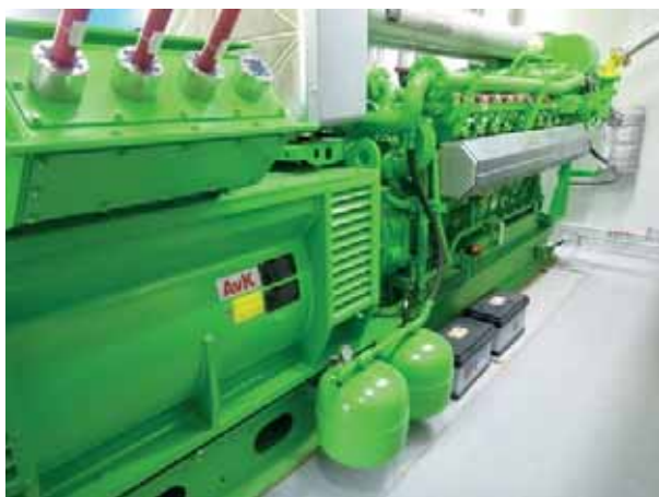
Plinska motor kogeneracijska enota SPTE 3
