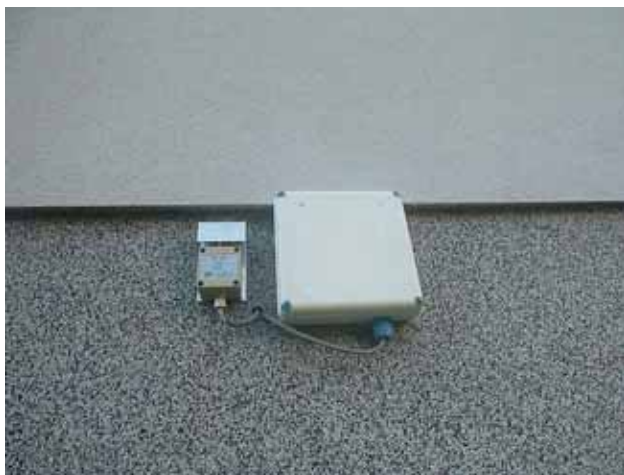
Antene na objektu za prenos komunikacij med toplarno in objektom
