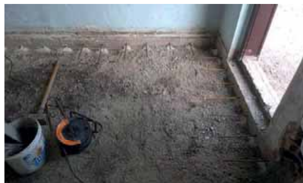
Obnova predprostora v objektu
