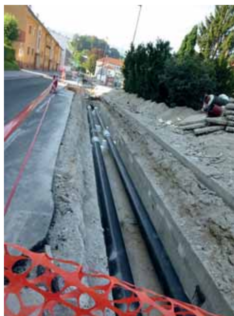
Obnova 3. faze, pogled proti občinski stavbi
