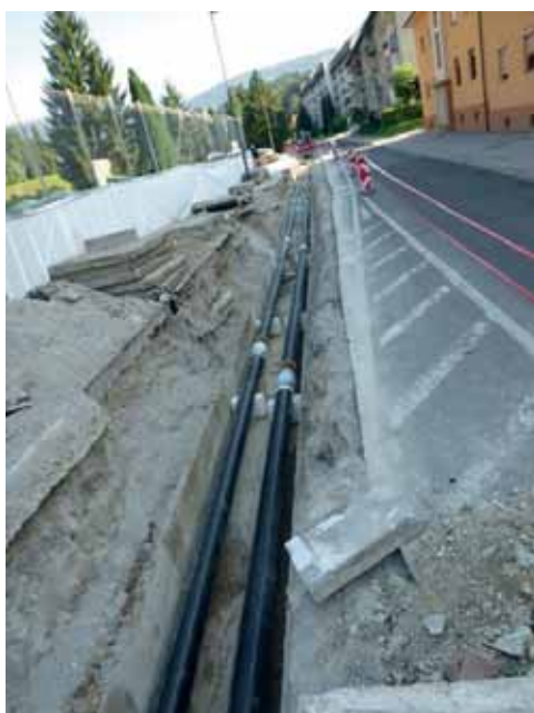
Obnova 3. faze, pogled proti Mercatorju
