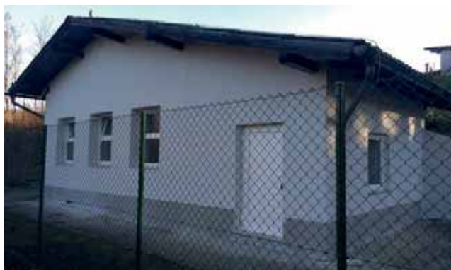
Vodohran Gvido po obnovi
