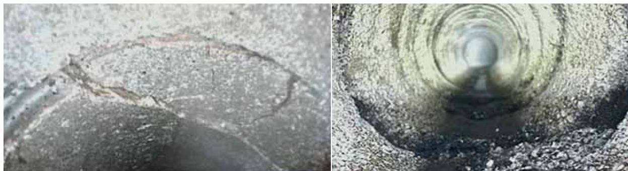
Poškodovana kanalizacijska cev
