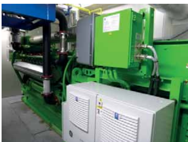
Oprema motor kogeneracijske enote SPTE 3
