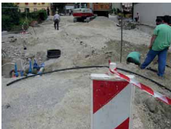
Obnova križišče Kamnikar-Zdravstveni dom Cevovodno vozlišče v križišču pri Kešetovo 4
