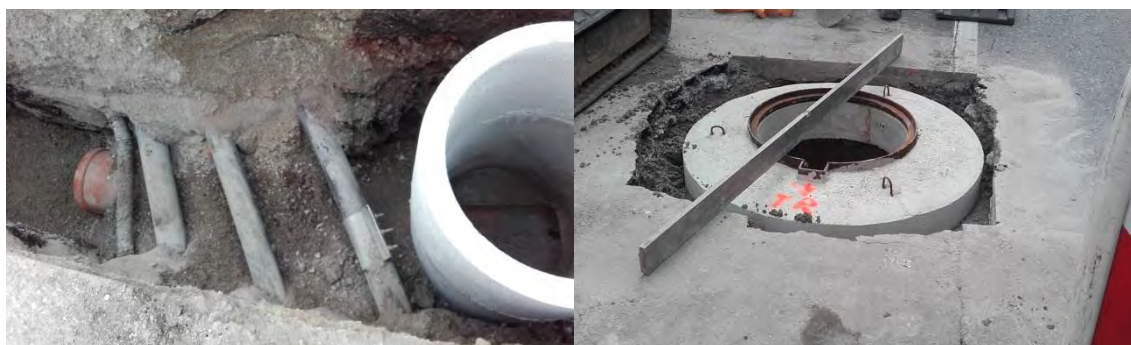
Obnovitvena dela na kanalizacijskem omrežju
