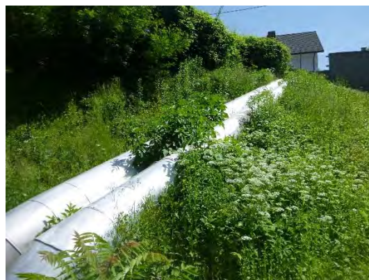
Vročevod pred obnovo poleg Spara
