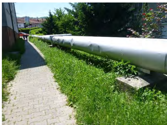
Vročevod pred obnovo Keršičeva 21a
