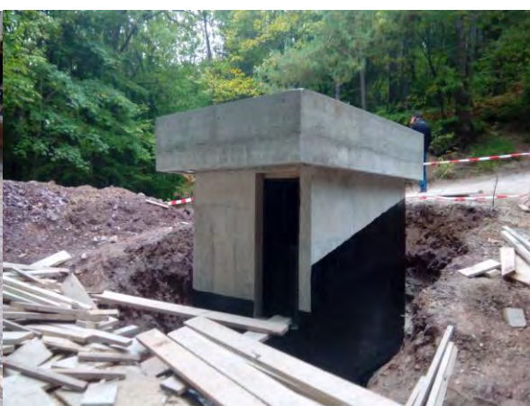
Izgradnja novega razbremenilnika
