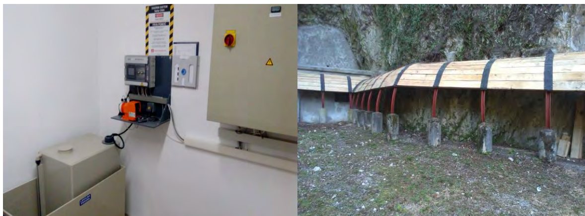
Nov klorirni sistem s posodo za shranjevanje klora
