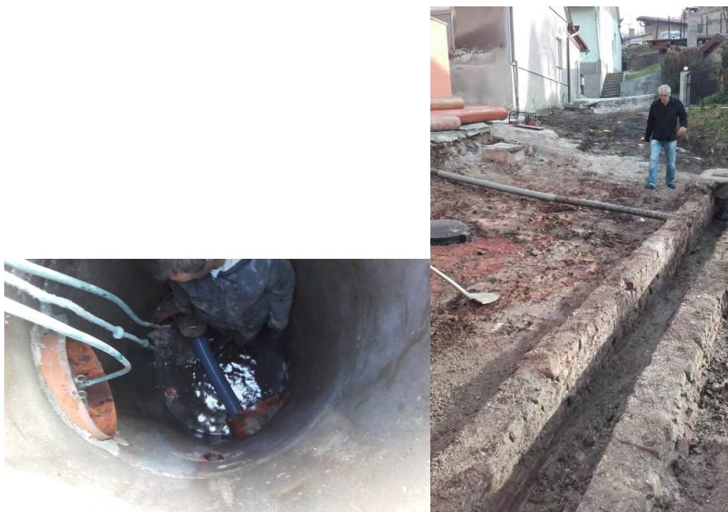
Obnovitvena dela na kanalizacijskem omrežju
