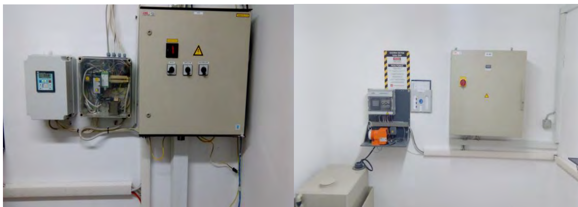
Klorirni sistem in elektro omara
