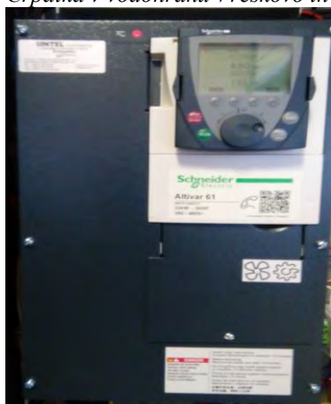
Frekvenčni regulator za črpalko VT 1
