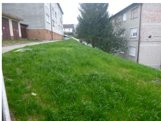
Po obnovi vročevod v zemlji
