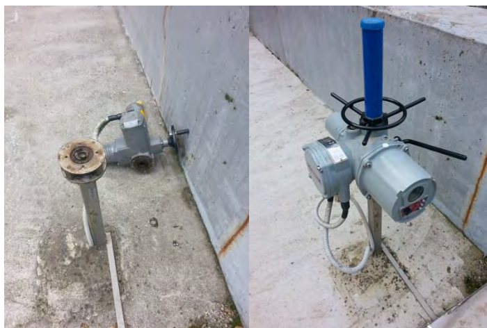
Okvarjen in nov elektromotorni pogon
