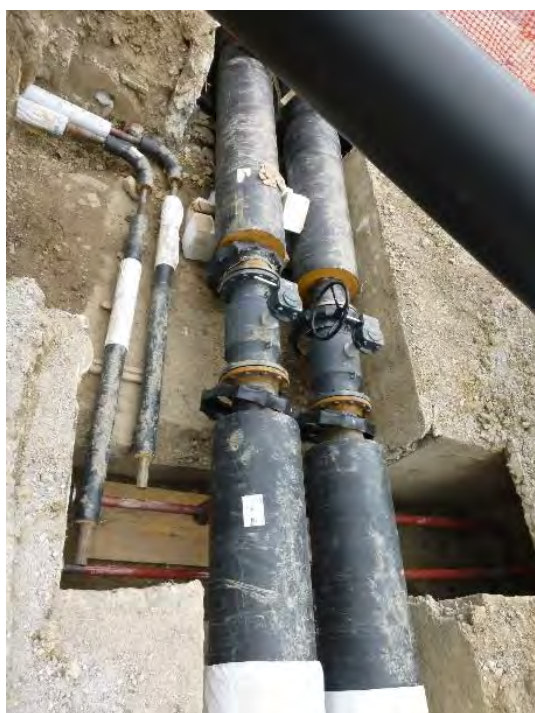
Novo vozlišče v jašku
