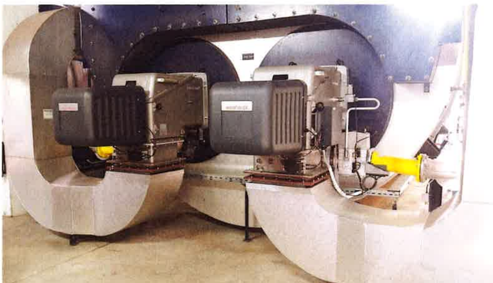
Na fotografiji: nova gorilnika pri kotlu 2HE
